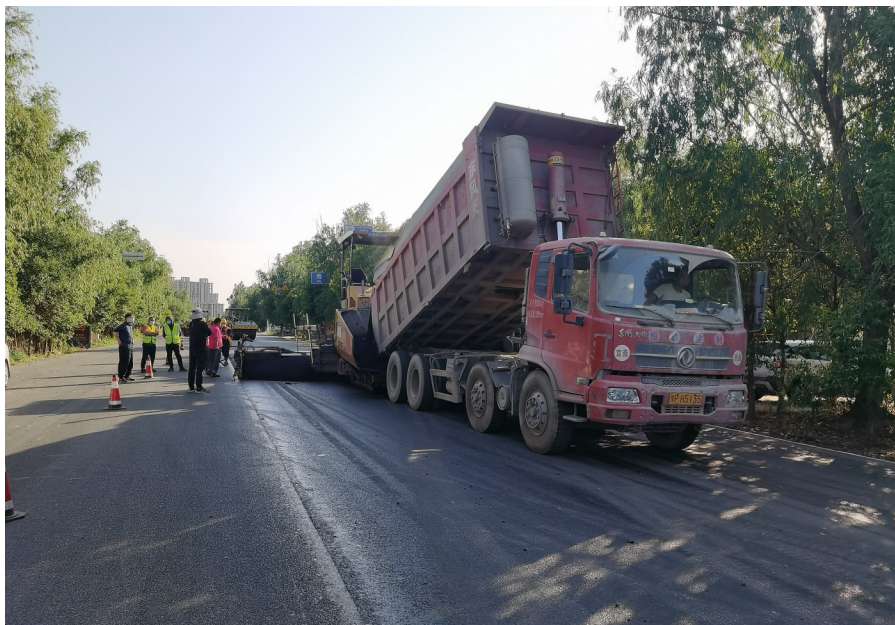
G234线郑许界至禹州东环路段改建工程施工现场 资料图片
