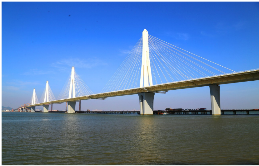
5日，我国首座公铁同层多塔斜拉桥——珠机城际金海特大桥成功合龙。
