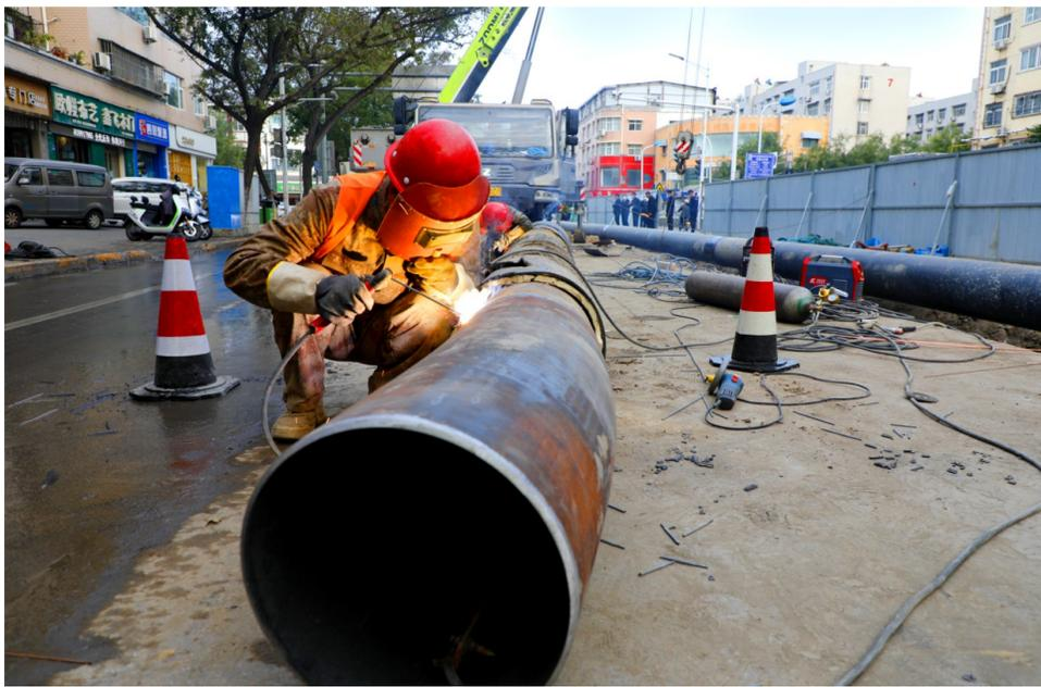
10月29日,中心城区“汽改水”项目东大街施工标段,工人正在对热力管道进行焊接。据悉,我市“汽改水”项目实施单位昼夜不停倒排工期,正在进一步加快施工进度,推动项目尽快完工。
