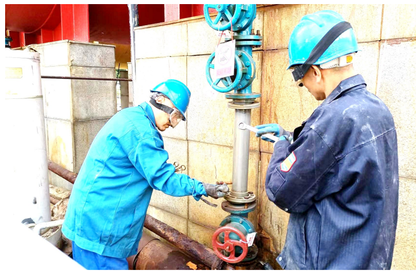
工人检修供热管道
