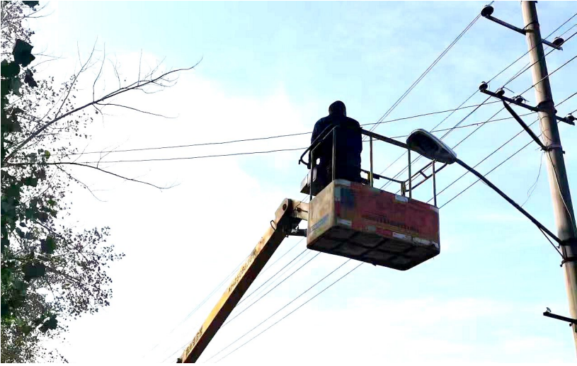
工作人员正对路灯进行维修。许廷合 摄
