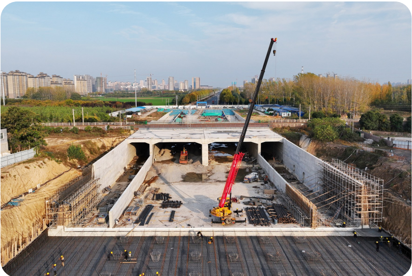
11月23日,位于建安区的新元大道下穿京广铁路桥及西延项目加紧建设。该项目建成后,将进一步完善建安区区域路网、缓解交通压力,有力促进区域经济发展。
