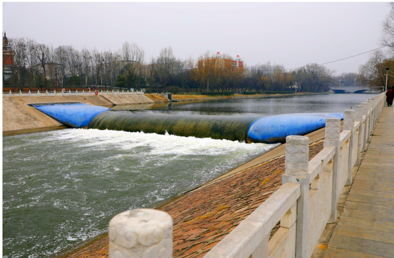
2月8日,许昌市水利局将清溧河滞涝闸至马岗闸段水体依次放空。据悉,我市统筹调度水源,于2月8日至2月12日实施中心城区河湖生态补水工作,提前应对春季可能出现的水华现象,有效改善中心城区河湖水系整体水质。
