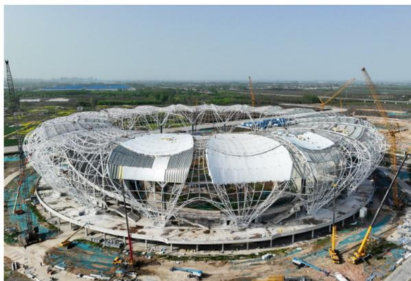
4月10日,位于建安区的许昌体育会展中心项目加紧施工。目前,该项目主体结构、钢结构架体等已完成,正在进行金属屋面施工,“莲花”造型展露“芳容”。 本报记者 乔利峰 通讯员 冯羽摄
