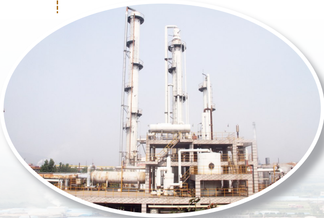
←河南平煤神马首山化工科技有限公司20万吨二甲醚装置
