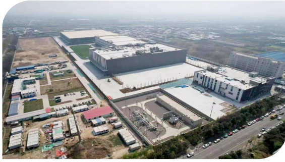
胖东来智能化综合生产基地项目
