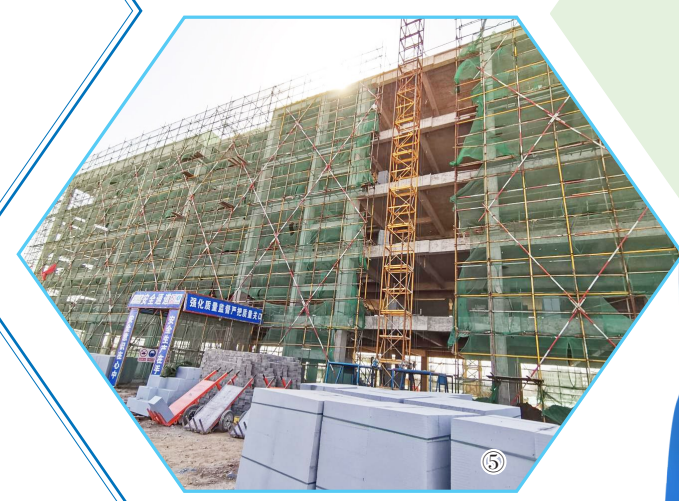
①魏都区区长何长成(前排中)到吾悦广场项目调研 ②德通5G+振动搅拌行业工业互联网平台项目 ③领存科技智能芯片生产线项目 ④京益求精医疗美容装备生产线项目 ⑤GTA智能隧道装备制造项目
