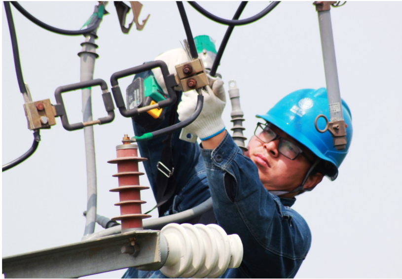
近日,国网长葛市供电公司员工对10千伏马武线进行设备安全隐患排查,为农田春灌提供安全可靠的电力保障。图为电力工人在长葛市南席镇全庄村作业。 本报记者 乔利峰 通讯员 桂小锋 摄
