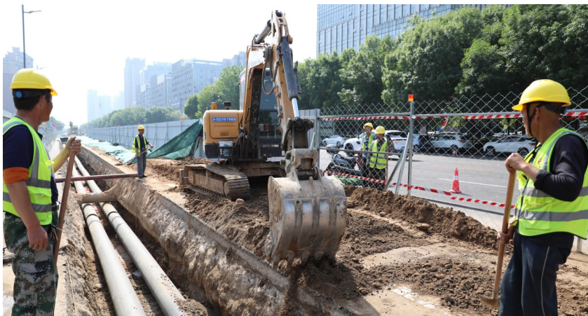
5月15日,市区许都路,工人正在加紧热力管网铺设施工。我市有序推进中心城区供热质量改善工程,提升中心城区集中供暖质量和保障能力。
