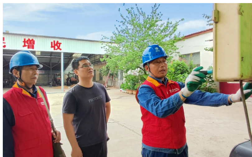
党员服务队队员在排查线路安全隐患。 焦永生摄
