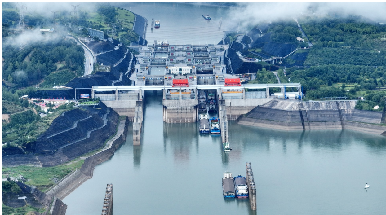
6月18日，船舶有序通过三峡双线五级船闸。统计数据显示，自2003年6月18日正式向社会船舶开放通航以来，20年间，三峡船闸累计运行超19.3万闸次，通过船舶99.3万余艘次、旅客1223.9万余人次，过闸货运量19.1亿吨。新华社发
