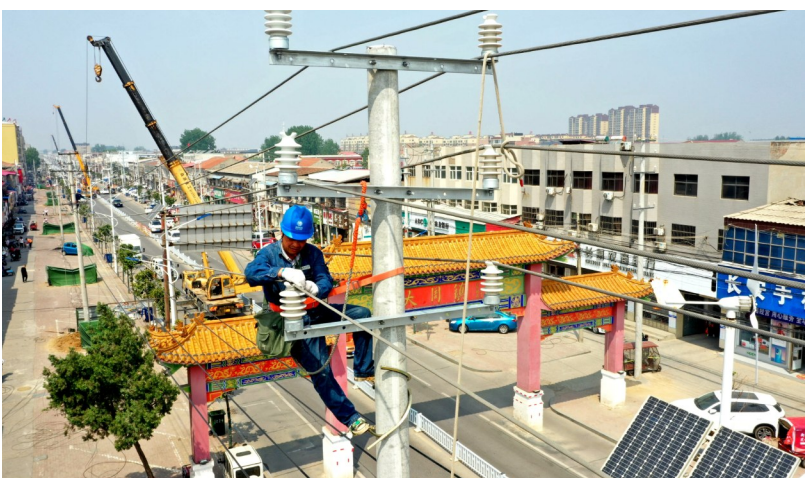
农村电网改造现场
