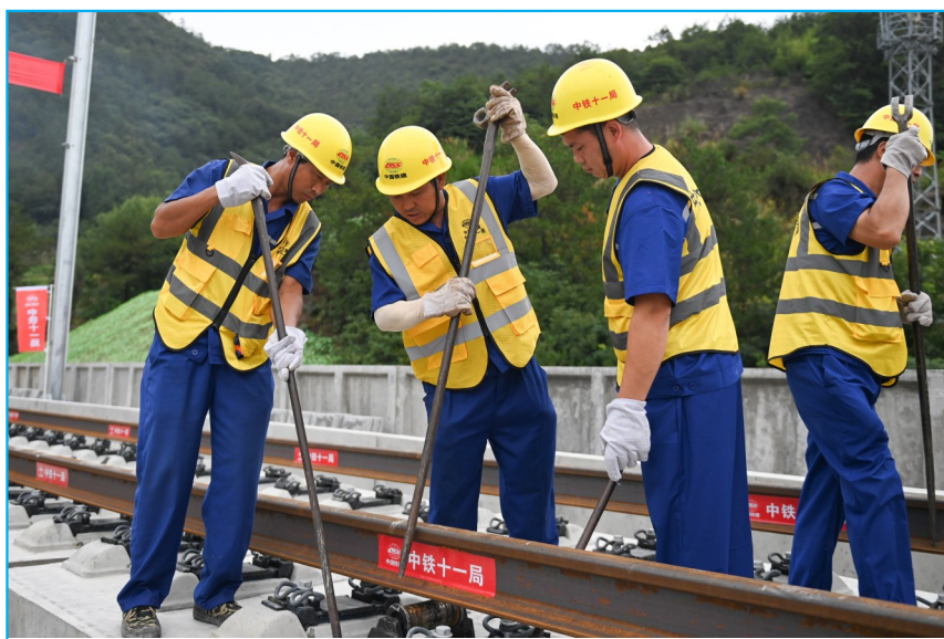
7月20日，中铁十一局施工人员在杭温铁路上进行铺轨作业。
