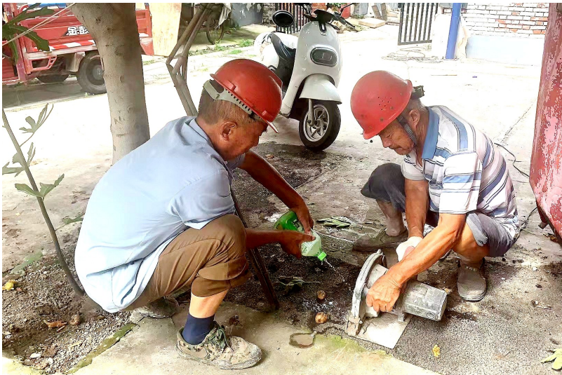
木材公司家属院供水管网改造施工现场。 孙江锋 摄
