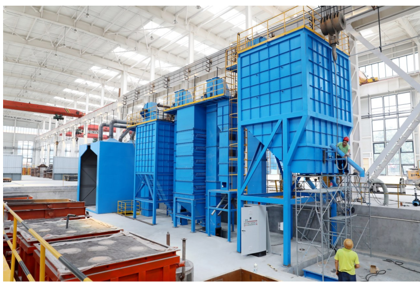
位于禹州市的河南纵横精工轨道交通装备生产项目 本报记者 乔利峰 摄
