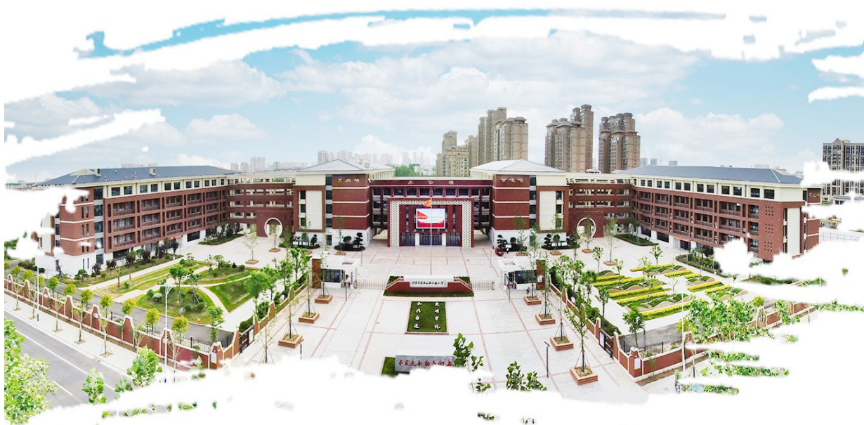
新建的建安区溧水路小学,让学生在家门口“上好学”
