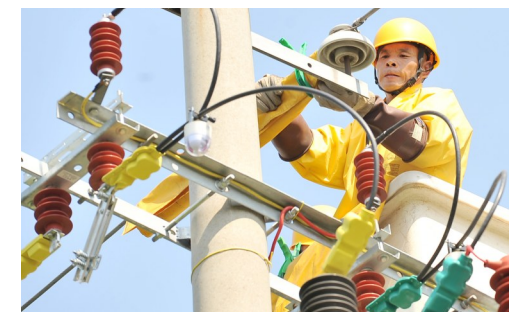
建安供电公司带电作业人员带电消除设备缺陷，保障设备安全运行，可靠供电。
