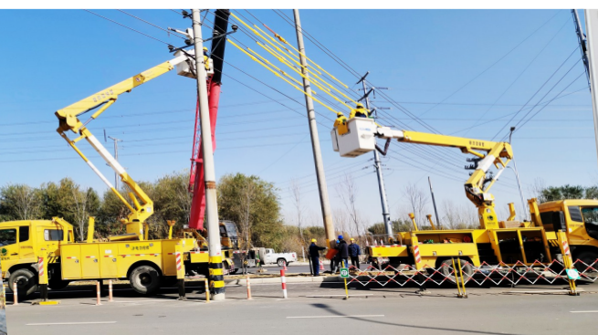
建安供电公司积极开展带电作业，更好服务广大人民群众用电需求。
