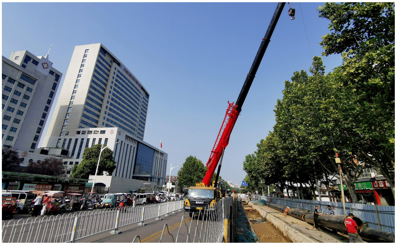
9月8日,市区前进路,大型机械正在吊装供暖管道。目前,我市中心城区“汽改水”工程加紧建设,部分道路封闭施工,行人、车辆注意绕行。 本报记者 乔利峰 摄
