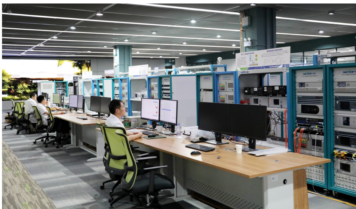
许昌开普检测研究院股份有限公司技术人员对电力保护与控制设备进行仿真试验。 本报记者 乔利峰 摄
