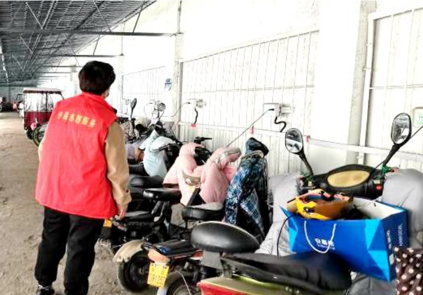
小区里安装了充电桩。 张铮 摄
