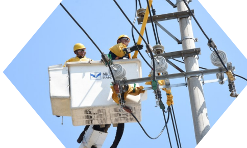
许昌供电公司配电运维人员在度夏期间开展不停电作业,检修线路故障。
