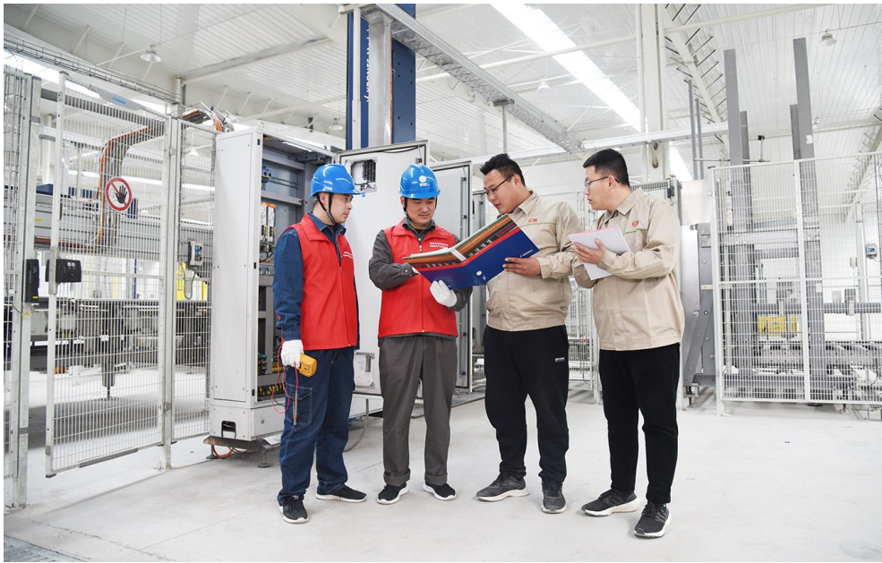
许昌供电公司供电服务人员到汇源集团百万吨陈化店矿泉水生产项目开展用电服务。
