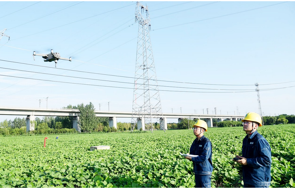
许昌供电公司输电运维人员利用无人机对线路进行巡视检查。
